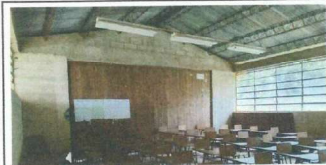
Foto 5: Se observa que el portón de la división del aula se encuentra en mal estado, presentando deterioro que afecta su funcionalidad y seguridad.
